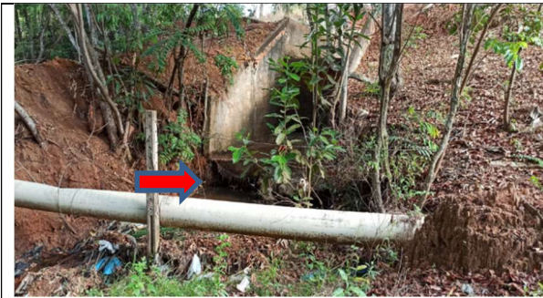
Saída do extravasor (vertedouro) com processo erosivo, rachadura na estrutura e presença de vegetação arbustiva.
