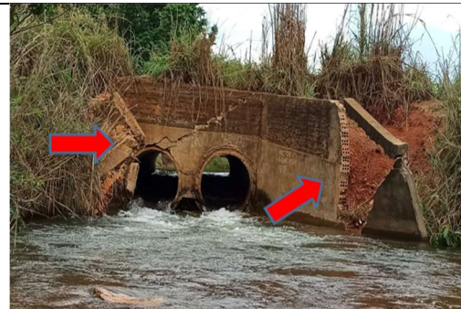
Saída do extravasor (vertedouro) com processo erosivo, rachadura na estrutura e presença de vegetação arbustiva.
