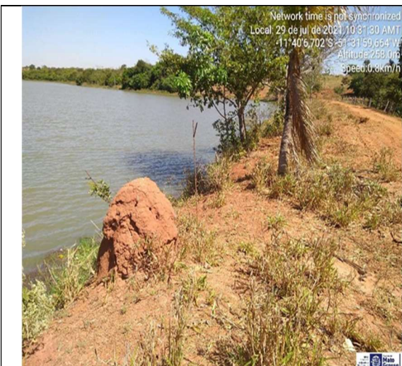
Cupinzeiro no talude de montante
