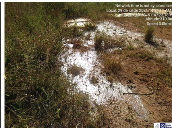
Visão geral de área alagada na região a jusante da barragem (pé da barragem e faixa logo a jusante do pé da barragem).
