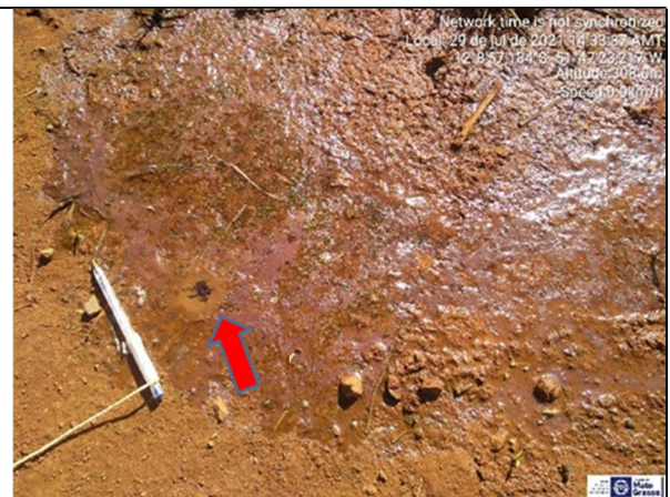
Ponto de surgência com fluxo de água constante (pé da barragem).
